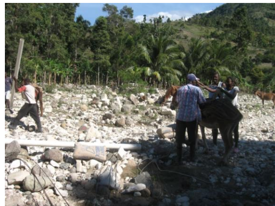
PHOTO 14: TRANSPORT MATERIEL DE CONSTRUCTION DES LATRINES FAMILIALES
