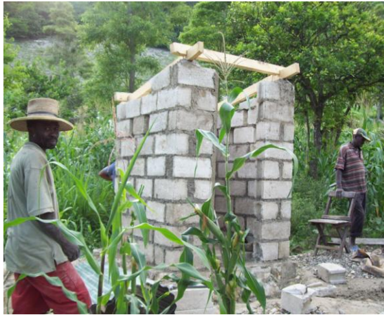
PHOTO 5: LATRINE FAMILIALE EN CONSTRUCTION
